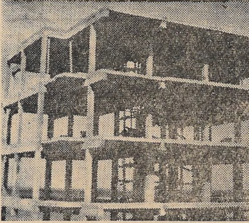
( طريقة حديثة لبناء الحرسان المسلح )
